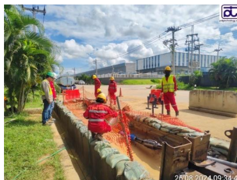
รูปที่ 2-15 การกันพื้นที่ระหว่างการก่อสร้างบ่อรับ-บ่อส่ง
