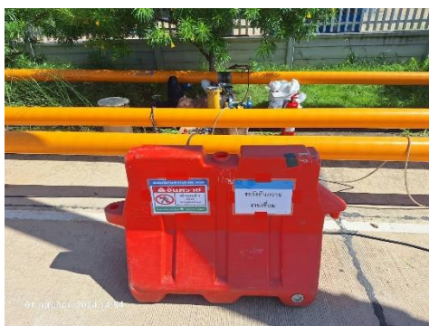
(ค) การติดตั้งป้ายเตือนแสดงเขตพื้นที่ทำการเชื่อมต่อ
