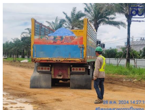
รูปที่ 2-7 การปิดคลุมรถบรรทุก และผูกมัดวัสดุและอุปกรณ์ก่อสร้างเพื่อป้องกันการตกหล่นขณะขนส่ง
