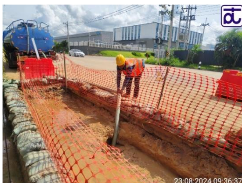
รูปที่ 2-15 การกันพื้นที่ระหว่างการก่อสร้างบ่อรับ-บ่อส่ง
