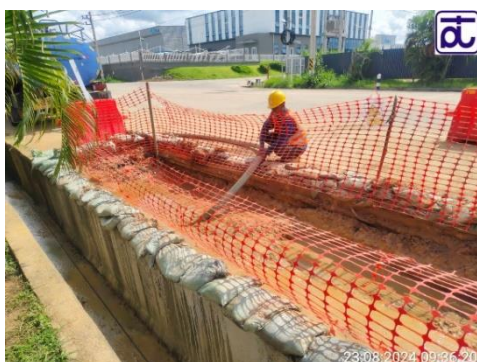
รูปที่ 2-39 พนักงานติดตามดูแลและอุปกรณ์กันพื้นที่ สำหรับเตรียมความพร้อมเพื่อป้องกันการรั่วไหลของโซเดียมเบนโทไนท์
