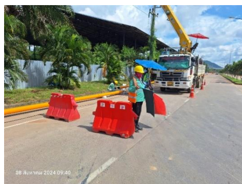
รูปที่ 2-32 วัสดุและแผงกันแสดงขอบเขตพื้นที่การก่อสร้าง
