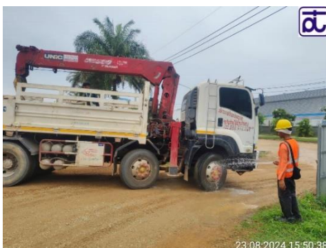
รูปที่ 2-12 การฉีดล้างล้อรถบรรทุกขนส่งวัสดุอุปกรณ์ของโครงการ
