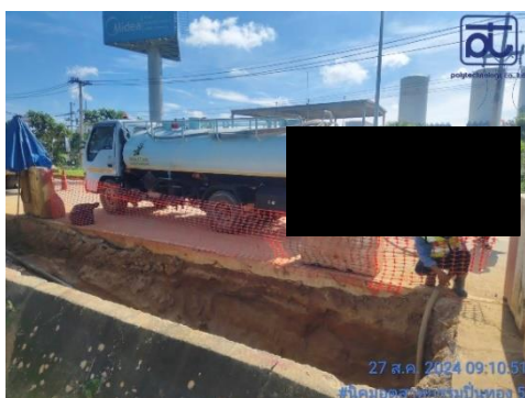
รูปที่ 2-36 รถดูดโคลนโซเดียมเบนโทไนท์ที่ปิดมิดชิด
