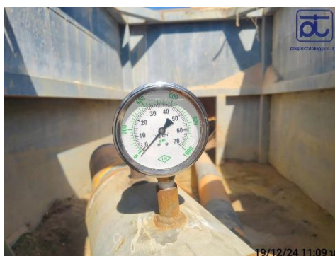
(3) ปรับลดแรงดันน้ำให้อยู่ในระดับความดันเทียบเท่าความดันบรรยากาศ ก่อนระบายทิ้ง
