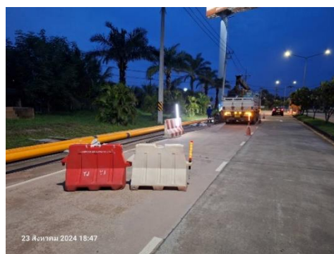
รูปที่ 2-31 ป้ายเตือนจราจรและสัญญาณไฟกระพริบ
