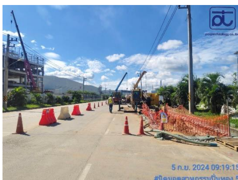
รูปที่ 2-44 การกั้นเขตพื้นที่บริเวณที่มีการติดตั้งเครื่องจักร เครื่องยนต์ และพื้นที่สำหรับจัดวางอุปกรณ์และเครื่องมือต่าง ๆ
