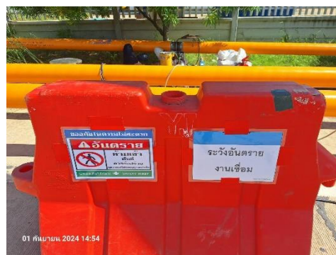
(ค) การติดตั้งป้ายเตือนแสดงเขตพื้นที่ทำการเชื่อมต่อ
