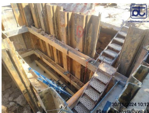
รูปที่ 2-17 เครื่องมือหรืออุปกรณ์ป้องกันการกล่มของดิน
