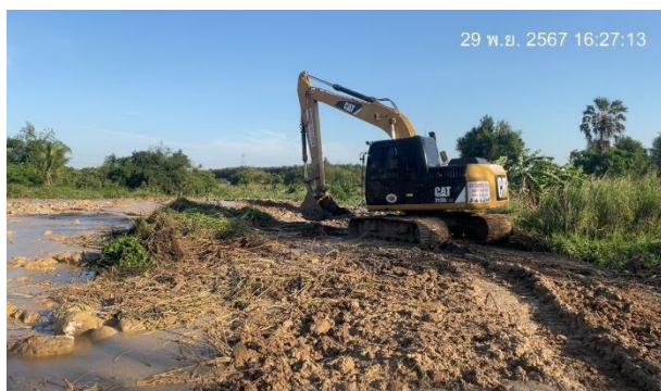
รูปที่ 2-38 การปรับสภาพพื้นที่ทิ้งโคลนเบนโทไนท์ และการส่งคืนพื้นที่ให้เจ้าของที่ดิน
