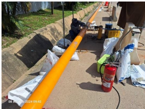
รูปที่ 2-48 การอบรมเพื่อเสริมสร้างทักษะในการเชื่อมต่อท่อตามข้อกำหนดการทำงาน (Procedure) ก่อนปฏิบัติงานจริง
