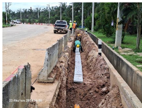
แผ่นคอนกรีตเหนือแนวท่อบริเวณตำแหน่งที่เป็นจุดเชื่อมต่อ (Tie-in)
