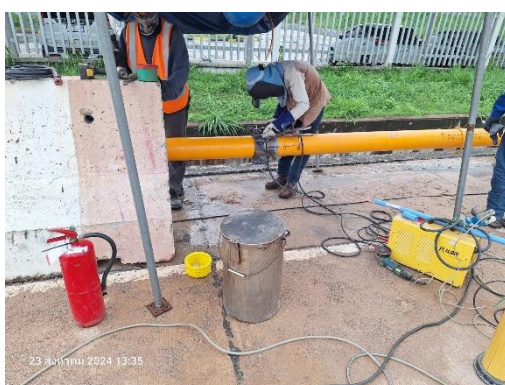
(ข) การปฏิบัติงานเชื่อมท่อฯ และการจัดเตรียมถังดับเพลิงบริเวณที่มีการเชื่อมต่อของโครงการ
