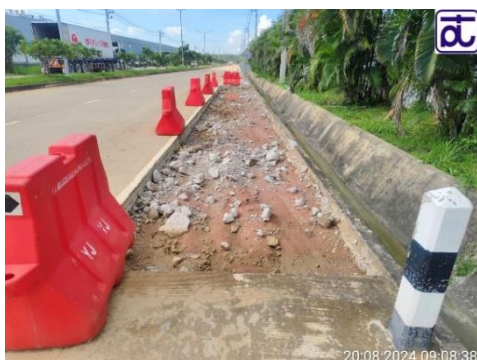
รูปที่ 2-3 รูปการขุดเปิดหน้าดินสำหรับวางท่อเป็นช่วง
