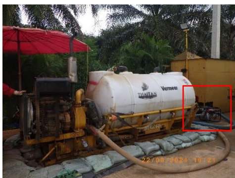
รูปที่ 2-27 เครื่องสูบน้ำสำรองที่จัดเตรียมไว้ในบริเวณพื้นที่ก่อสร้าง
