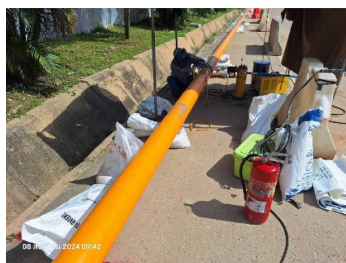
(ข) การปฏิบัติงานเชื่อมท่อฯ และการจัดเตรียมถังดับเพลิงบริเวณที่มีการเชื่อมต่อของโครงการ
