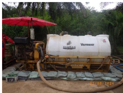
รูปที่ 2-28 การจัดเตรียมถุงทรายหรือคันดินป้องกันการรั่วไหลของโคลนขุดเจาะ
