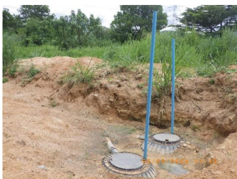
รูปที่ 2-20 ถังบำบัดน้ำเสียสำเร็จรูปของสำนักงานสนามชั่วคราวของโครงการ
