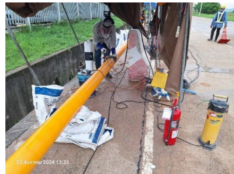
รูปที่ 2-48 การอบรมเพื่อเสริมสร้างทักษะในการเชื่อมต่อท่อตามข้อกำหนดการทำงาน (Procedure) ก่อนปฏิบัติงานจริง
