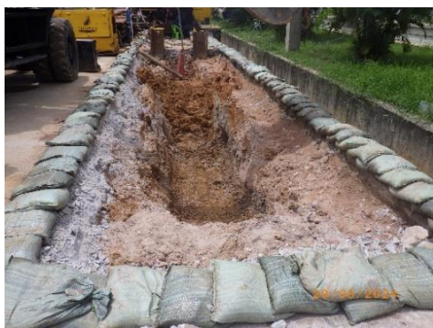
รูปที่ 2-28 การจัดเตรียมถุงทรายหรือคันดินป้องกันการรั่วไหลของโคลนขุดเจาะ
